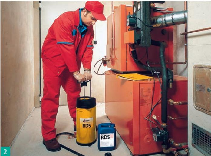
**2** Mit dem „RDS“-Verfahren zur zerstörungsfreien Leckreparatur (Rohrabdichtung von innen) können auch im Ein- und Mehrfamilienhaus kleinste Leckagen abgedichtet werden. Hierzu muss keine Fliese zerstört werden. (Foto: Lindenberg-Ortungstechnik).
