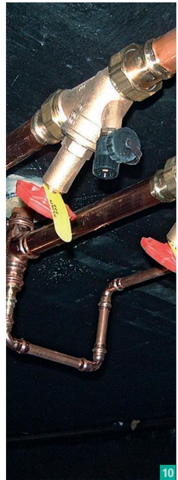
**10** Ein Großteil der deutschen SHK-Betriebe setzt auf Pressverbindungen. Aber auch die klassische Verschraubung ist noch nicht „ausgestorben“, wenn zum Beispiel wie hier ein Ventil zusätzlich mit dem Rohr verbunden wird. (Foto: Martin)
