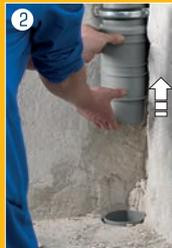
2 Schiebemuffe über oberes Rohr schieben.
